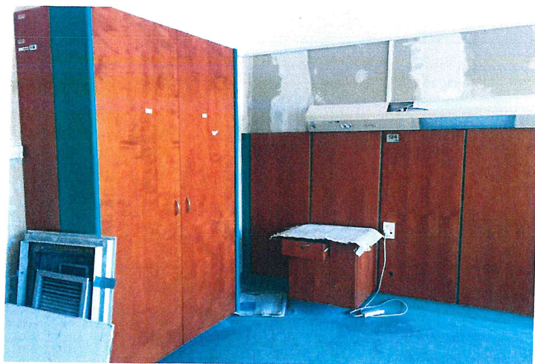
Foto 4: arredi interni lignei
