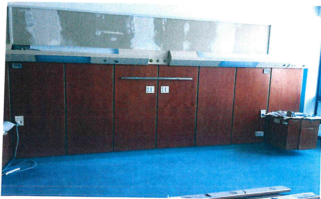
Foto 5: arredi interni lignei
